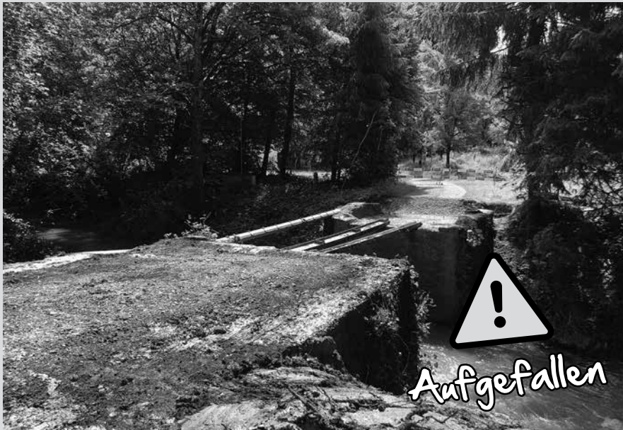
Die Sanierung des Brückleins über den Chemibach zwischen Märstetten und Wigoltingen hat begonnen.
