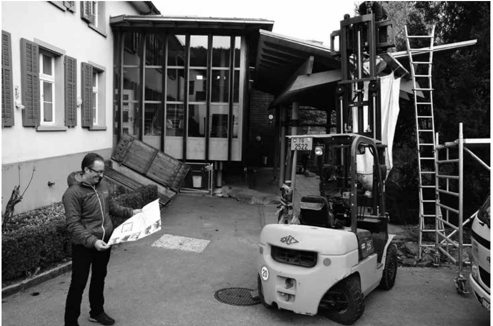
Baukommissionspräsident Reto Schubnell beobachtet den Beginn der Bauarbeiten am Schulhaus Ottoberg.
