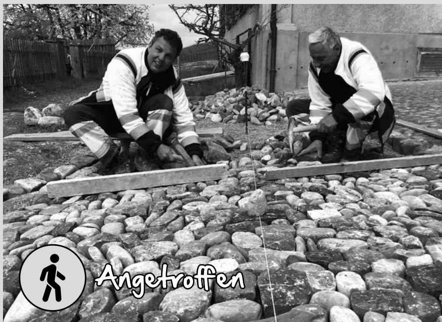
Sohn Roger und Vater Edwin Bayer beim Versetzen von Bollensteinen auf einem Hofplatz in Boltshausen.
