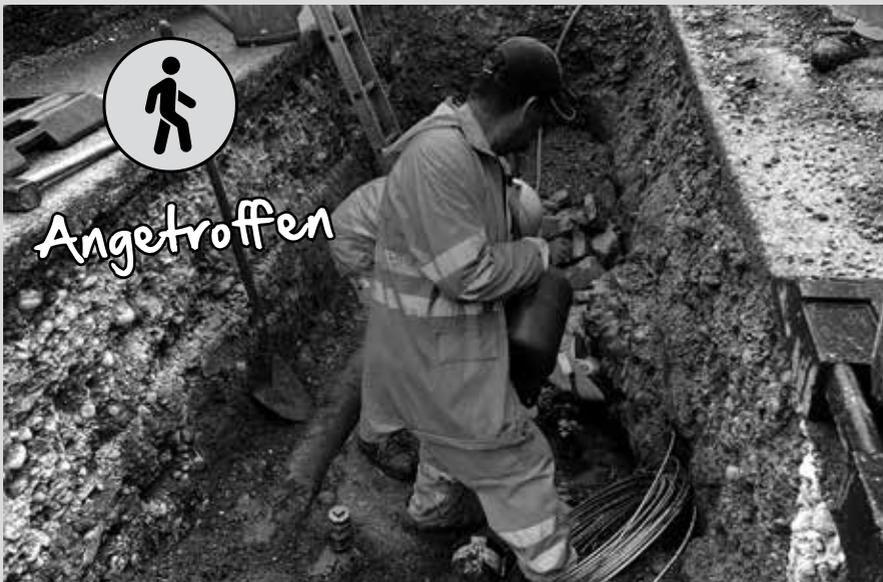
Beim Öffnen der Leitungsgräben am Höhenweg, im Bereich Abzweigung Webergasse, kam ein grosser Granitfelsen zutage. Dieser musste mit der Trennscheibe in kleine Stücke zerlegt werden.
