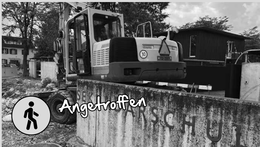
Abbruch der 25-jährigen Weitsicht-Mauer
