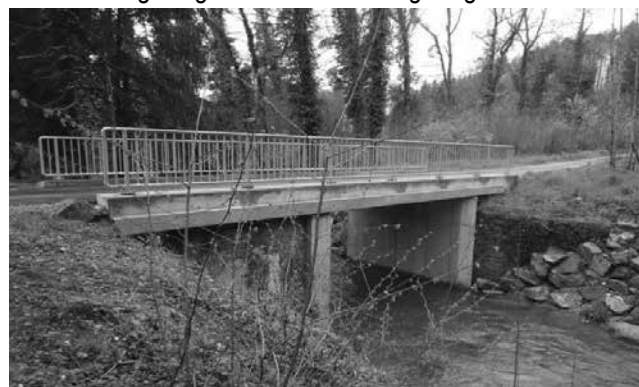
Abbildung 1: Die Klingenmühle-Brücke präsentiert sich im neuen Kleid
