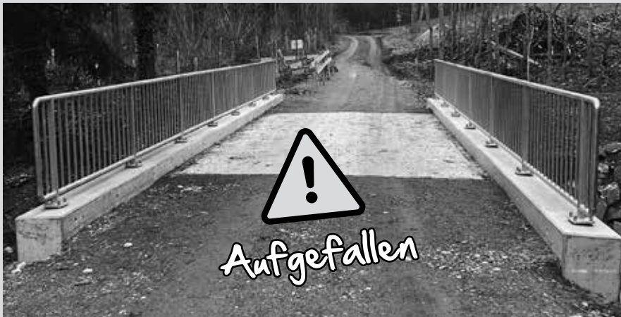
Die seit Mitte Juni gesperrte Brücke zwischen Wigolingen und Märstetten (Klingmühle) ist fertiggestellt.
